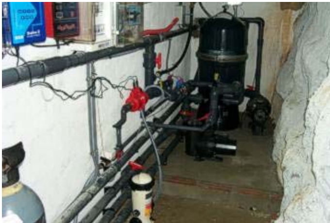
Filtración Simple de Diatomeas. El sistema de mejores resultados y actualmente no tan caro ni tan complicado de manejo como antaño.
