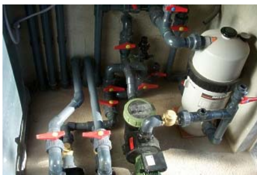
Este equipo de Filtración, emplea DIATOMEAS. es uno de los métodos más eficaces conocidos en la actualidad.
