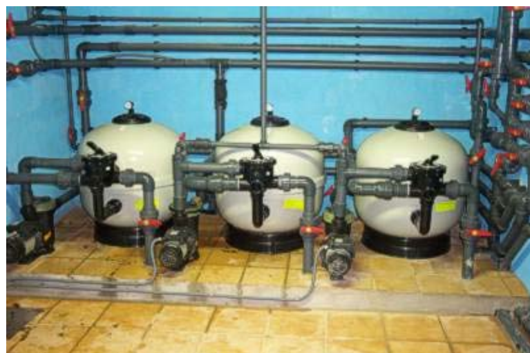
Los sistemas de filtración en paralelo cumplen multiples misiones. Para nosotros la más importantes son: redundancia, seguridad y mejora de la calidad del filtrado en sistemas tan poco agraciados como los de SILEX .
