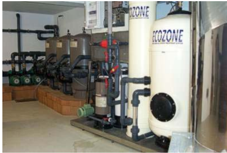
Sistema totalmente automatizado de filtración TANDEM/PARALELO de Zeolitas + Diatomeas. Como se puede observar con algunas cuantas "cositas" más, que no vienen a cuento.... =:O
