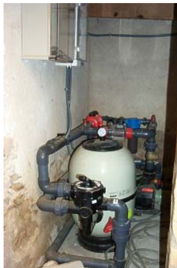
Equipo de Filtración, habitualmente empleado como medio de tratamiento Físico.
