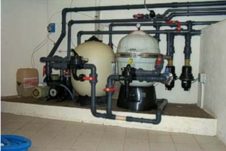
Filtración DUAL de zeolitas + Diatomeas. Actualmente el mejor sistema sin discusión alguna. Se requiere de altos conocimientos y experiencia reconocida para coordinar satisfactoriamente un sistema de este tipo.
